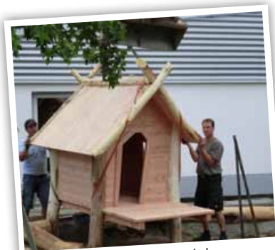
Mit Hilfe des Baggers, wird das von Jürgen Heitz gebaute Spielhäuschen, im zukünftigen Sandbereich aufgestellt.
